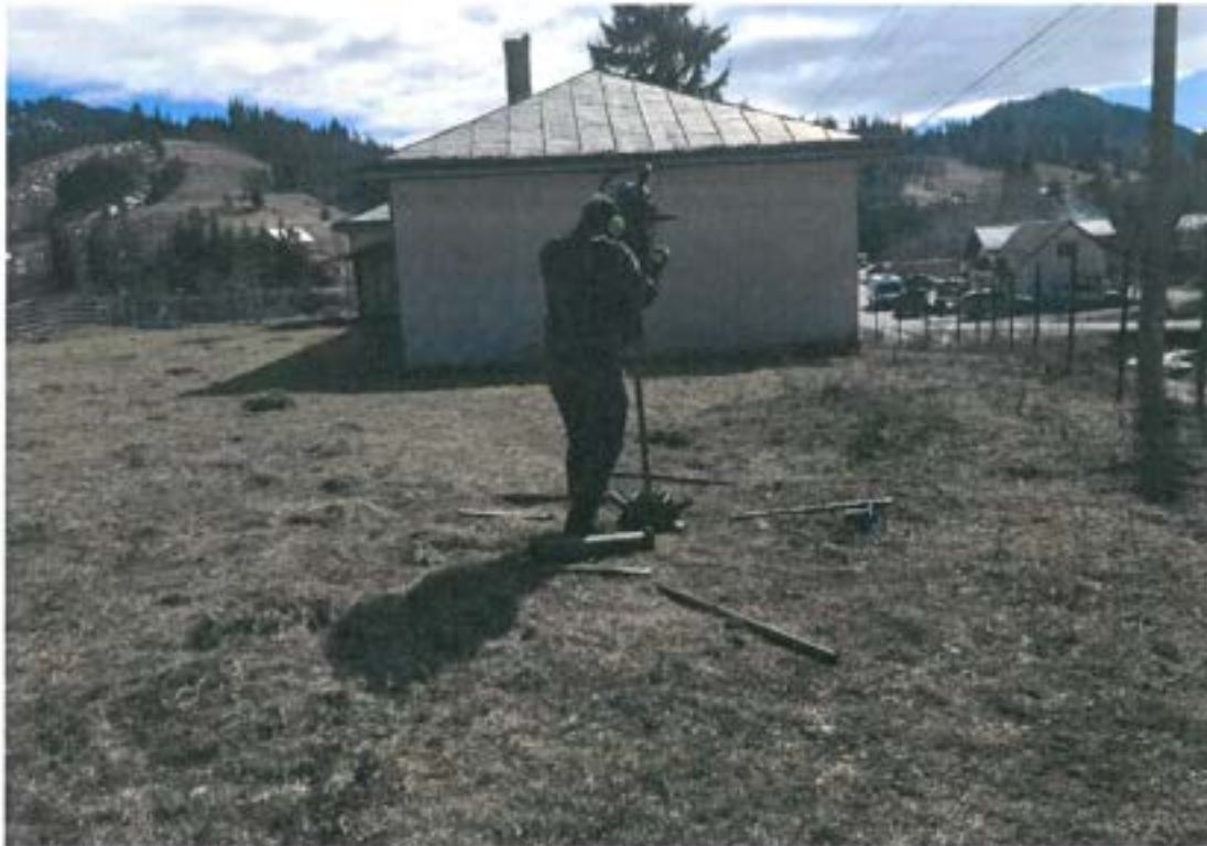
Figura 3.1. Aparatura folosita la realizarea studiului geotehnic
